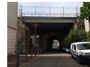
Rue du Parc/voie ferrée
