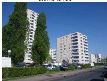
Arbre majestueux : rivalise avec les hauteurs du bâti et relève du grand paysage
