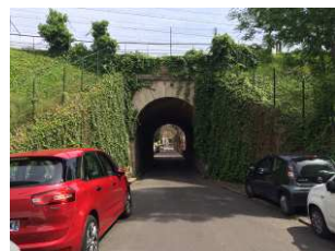
Rue du parc/voie ferrée
