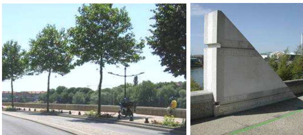
Murette en bordure de Seine Source Composante Urbaine
