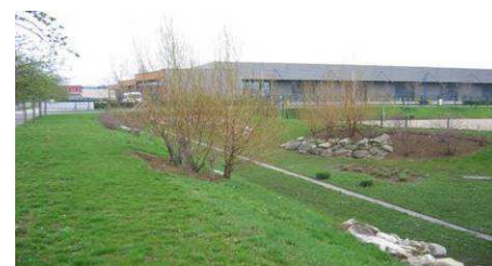
Bassin de rétention – ZAC Val de Seine Source : Composante Urbaine.
